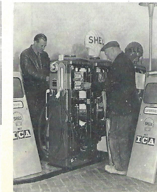
In de proefruimte wordt de pomp getest. Het koperen toestel rechts is de gecalibreerde meetkolf.
